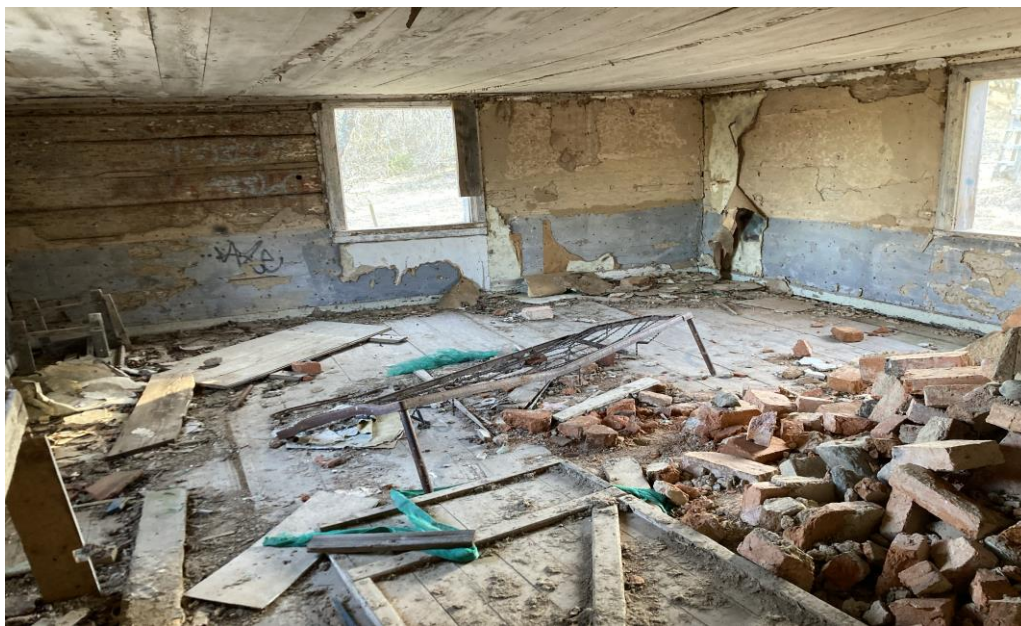
Figur 17 Mangårdsbyggnadens vardagsrum är reveterad
